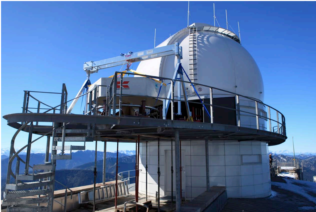
Die Kuppel des Wendelstein-Observatoriums; in der Bildmitte ein Container mit einem Spiegelement
